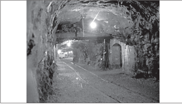
▲ شکل ۳۰- تونل‌های احداث شده در معدن
