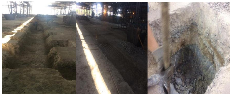
شکل ۲: گودبرداری از فونداسیون کف
