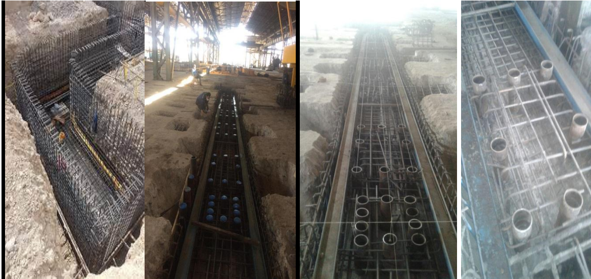
عکس ۳ شبکه آرما توربندی کف فنداسیون
