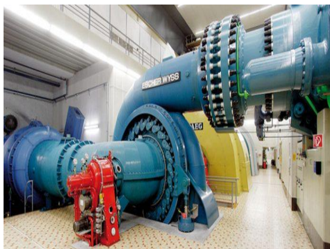
شکل ۴: پمپ آب برای انتقال مایع اشباع پر فشار
