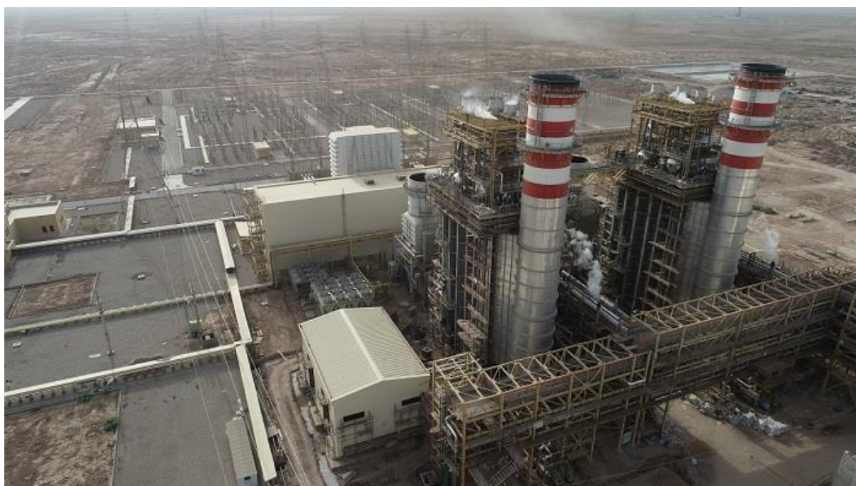
شکل ۱: واحد بخار نیروگاه سیکل ترکیبی غرب کارون
